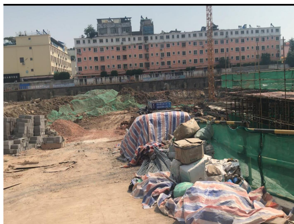
主体工程区已有临时排水沟、临时覆盖措施（根据项目进度已撤销）
