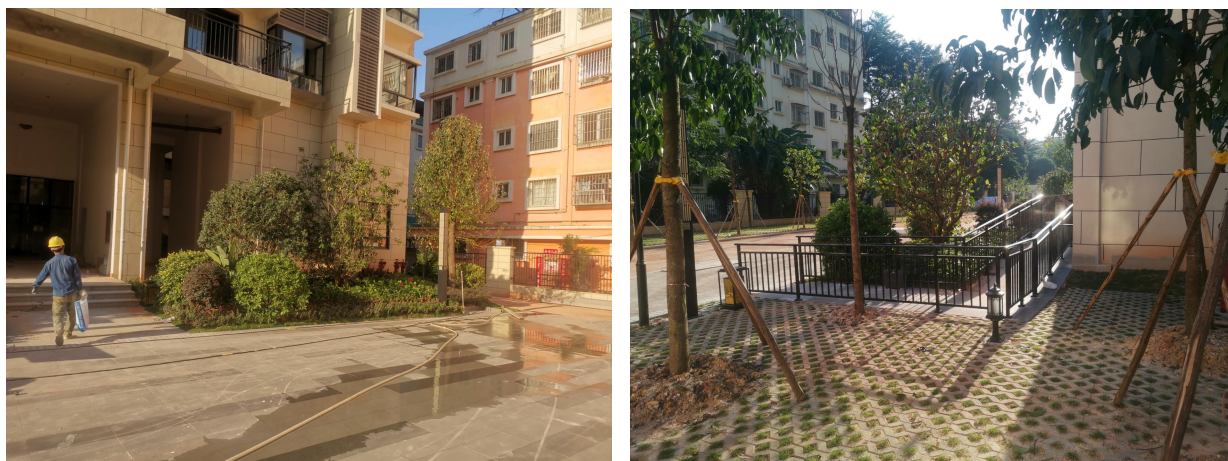
主体工程区已有综合绿化措施
