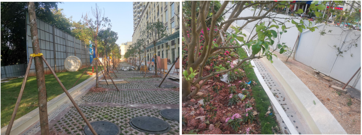
主体工程区已有综合绿化、盖板排水沟措施
