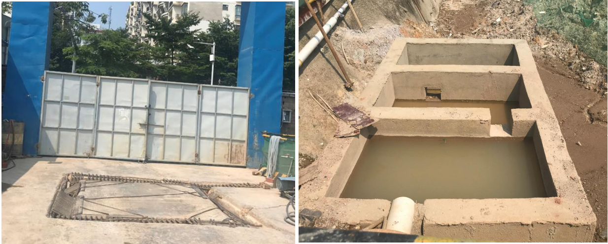
主体工程区已有洗车池及沉沙池措施（根据项目进度已撤销）
