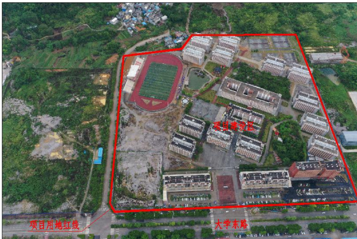
项目区航拍图
