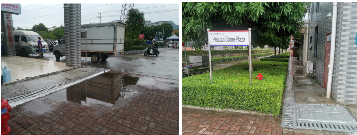
建构筑物周边盖板排水沟及景观绿化
