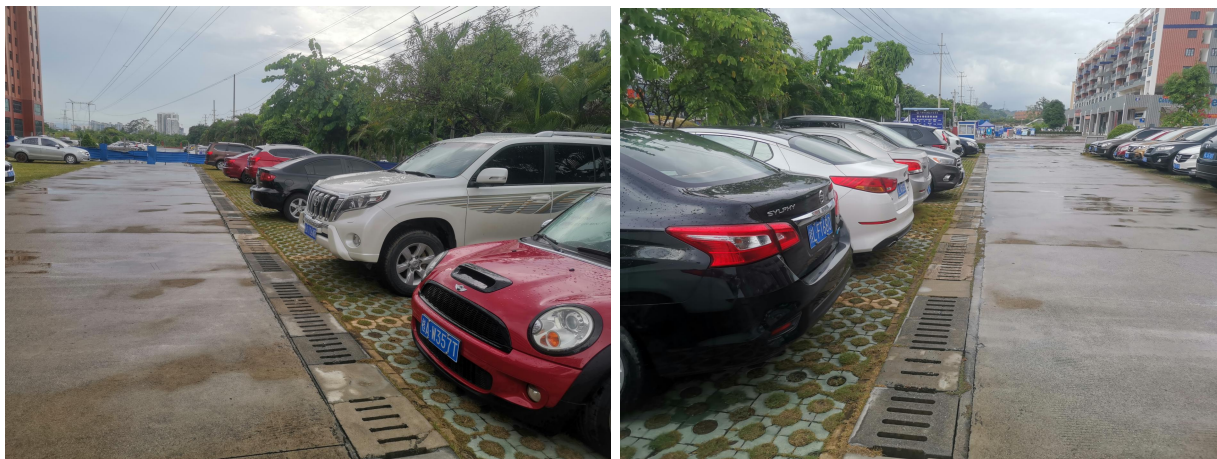
盖板排水沟及生态停车位
